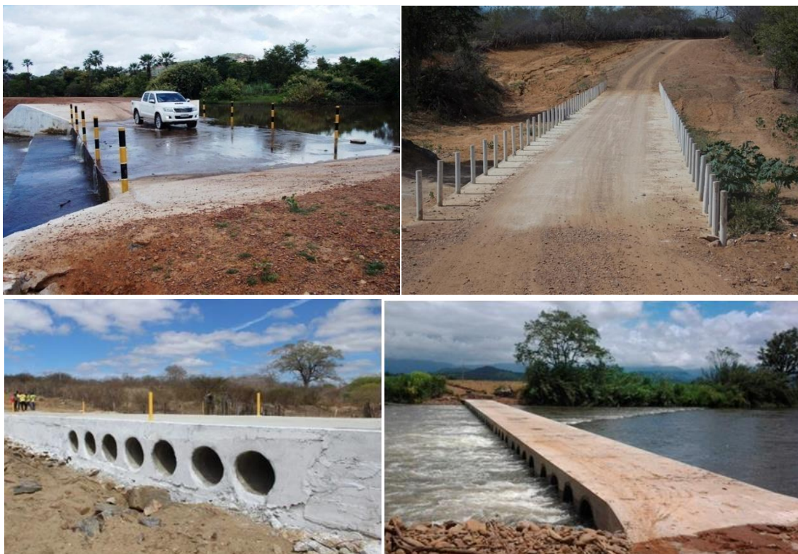
FIGURA 7: PASSAGENS MOLHADAS VASADAS COM MANILHAS
